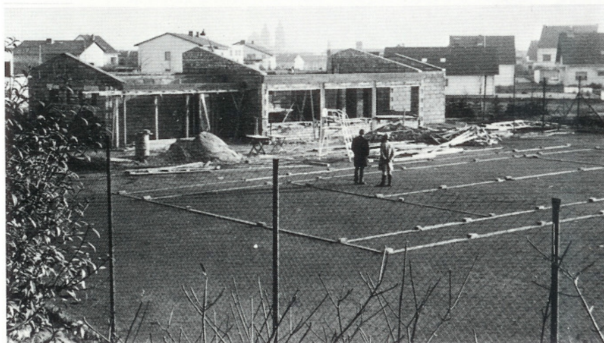
Das neue Clubhaus in der Entstehung.
